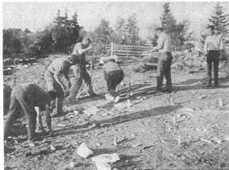
Det var foretatt fjellboring og klargjort for sprengning. Det gjensto bare å trykke på knappen når byggetillatelsen forelå.
