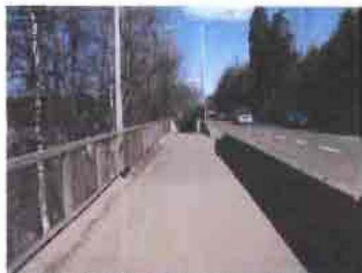
Figur 16. Gang- og sykkelvei rampen sett mot nord fra E18 Mosseveien.
