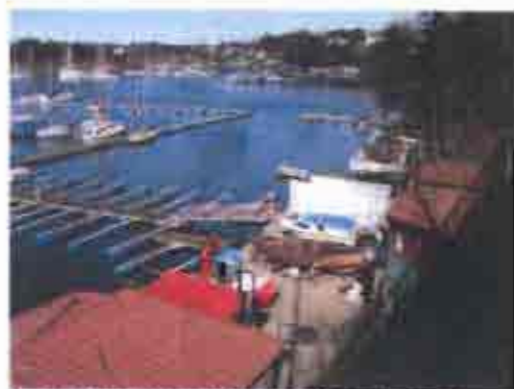
Figur 18. Mosseveien 171/Sandkroken Slipp sett mot nord fra Mosseveien.
