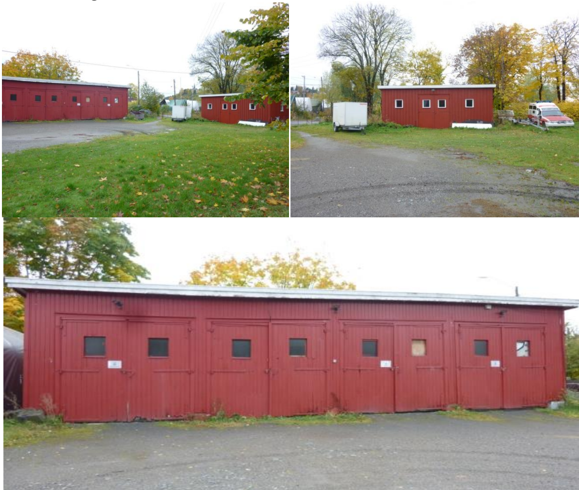
Foto: Byantikvaren i Oslo, oktober 2012.
