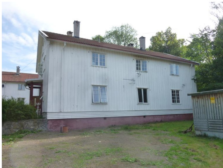
Kasernebygg B/4. Foto: Byantikvaren i Oslo, september 2013.
