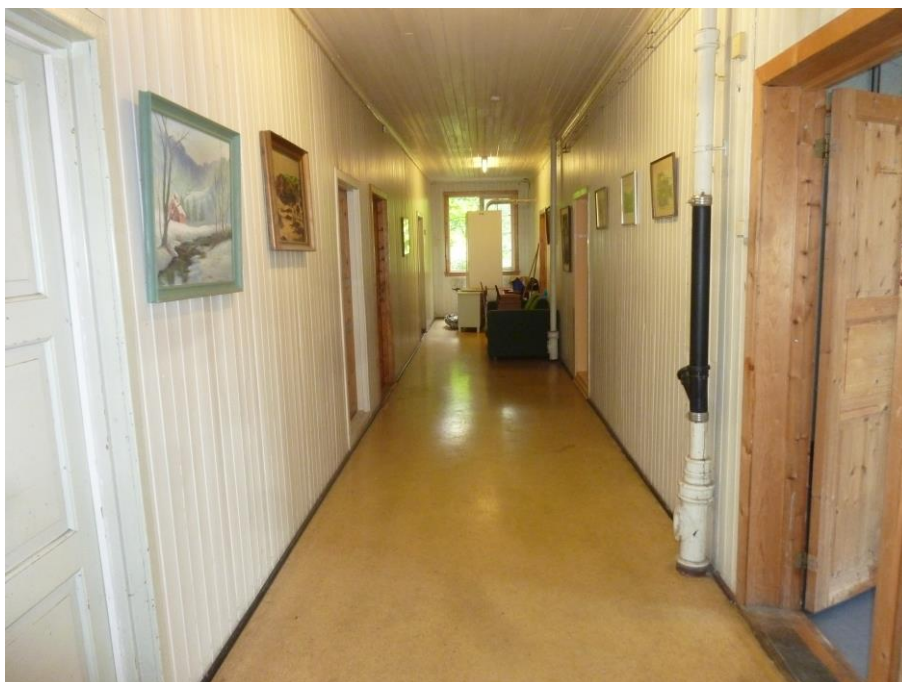
Korridor 1. etg. Foto: Byantikvaren i Oslo, september 2013.
