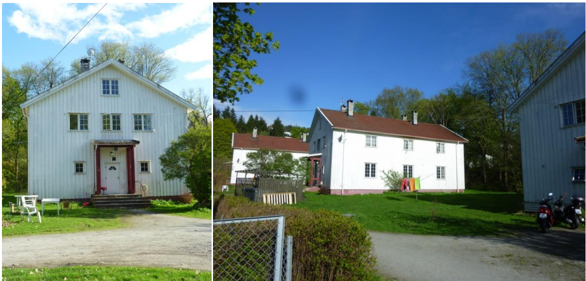
Foto: Byantikvaren i Oslo, april 2012
