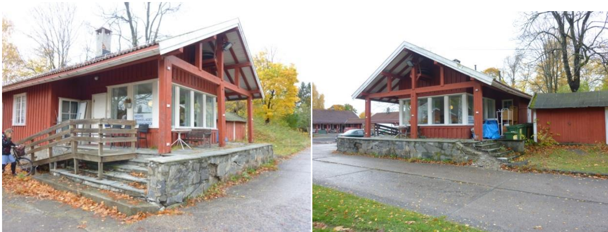
Foto: Byantikvaren i Oslo, oktober 2012
