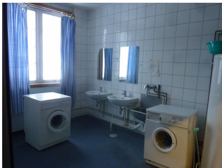
Vaskerom. Foto: Byantikvaren i Oslo, januar 2014.
