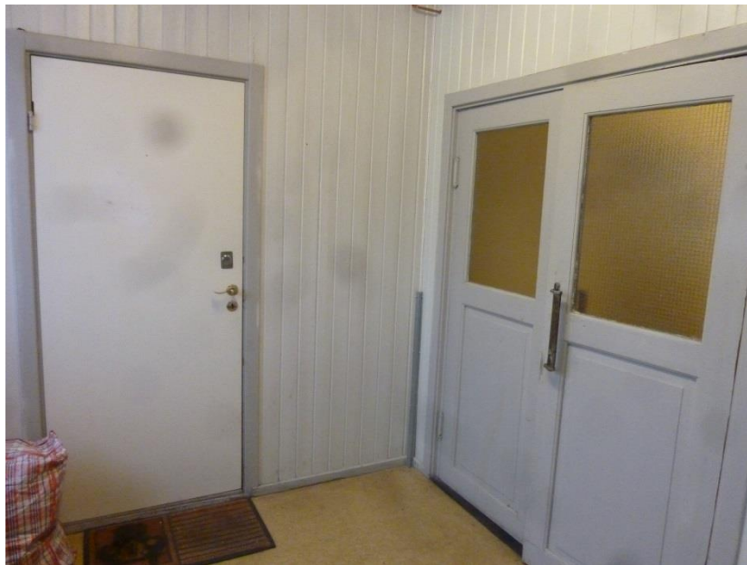
Trapperepos 2.etg. Foto: Byantikvaren i Oslo, januar 2014.
