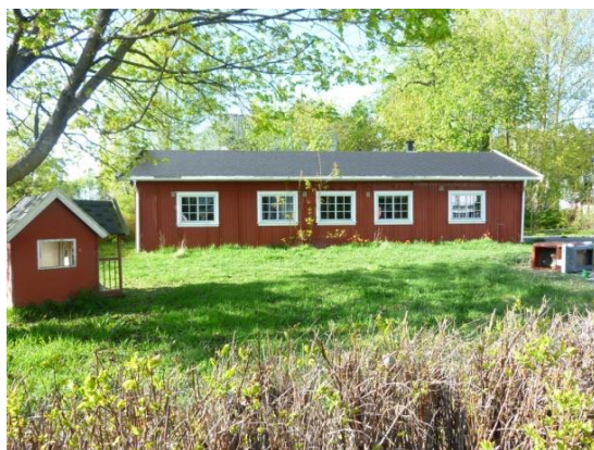
Foto: Byantikvaren i Oslo, oktober 2012.
