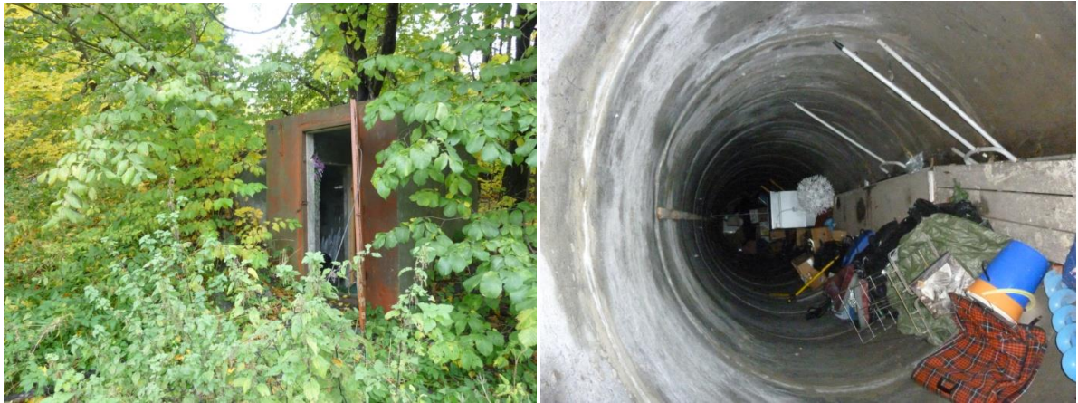
Bunkere. Foto: Byantikvaren i Oslo, oktober 2012.
