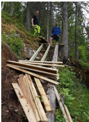
Kurt Selnes og Bjørn Marius Hansen under bygging av traseen
