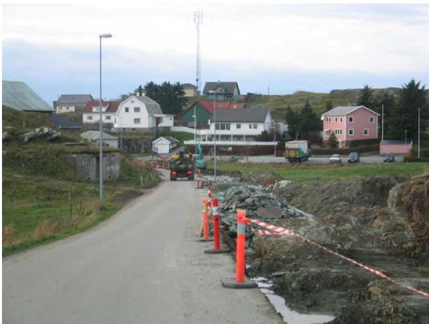
Arbeidet med fortauet fra Meling til Haaland er godt i gang.
