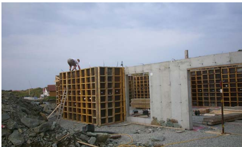
Tore Greibesland i full sving med grunnmuren.
