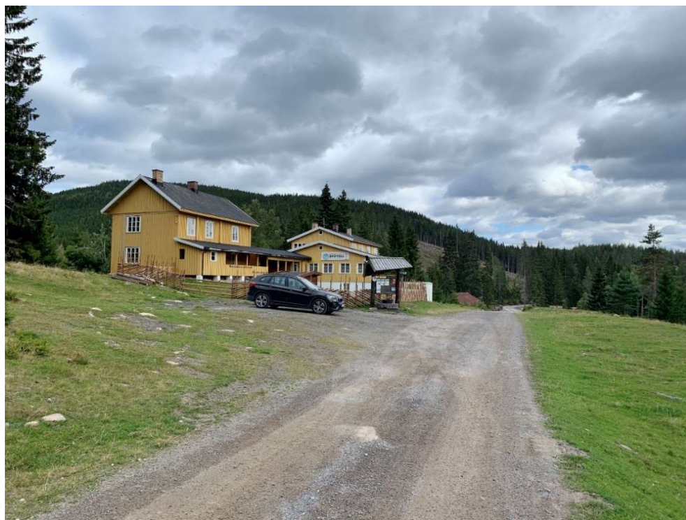
Brovoll skistue. Start ved broa i bakgrunnen. Bagasjeinnlevering der bilen står. Toalettvogn ved det borteste bygget.
