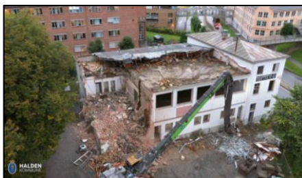
Rivning av Halden Bad- 2021
