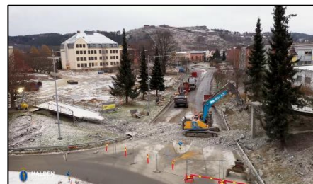
Rivning av Gangbrua grunnet setningsskader - 2022
