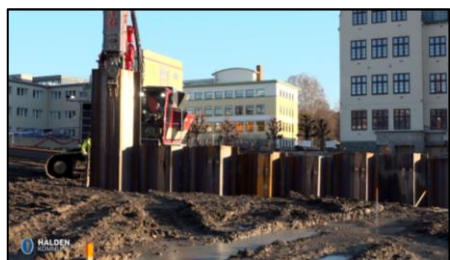
Spunting flytting av OS bekken i basishall
