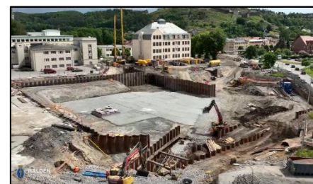
Støpt dekke i Arena
