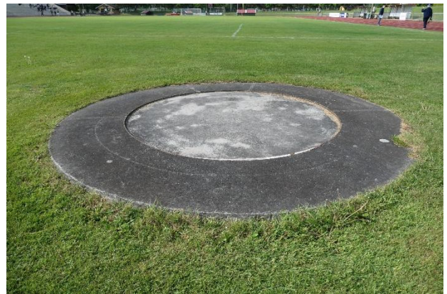
Diskosring inne på anlegget er også litt ru i overflaten.
