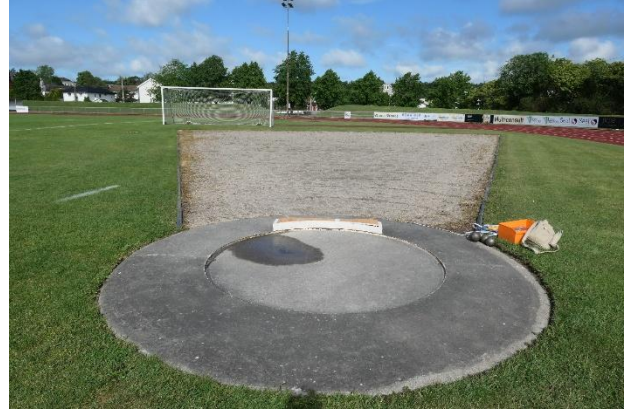
Kuleringen er litt ru og i kulesektor gror det gress. Stoppebrettet bør repareres eller skiftes.
