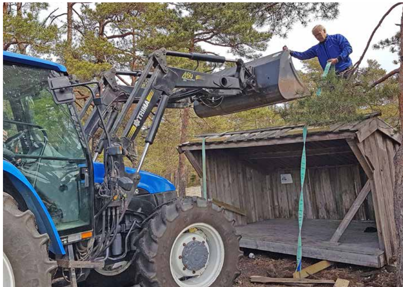
Løfting forberedes. Svein på taket.
