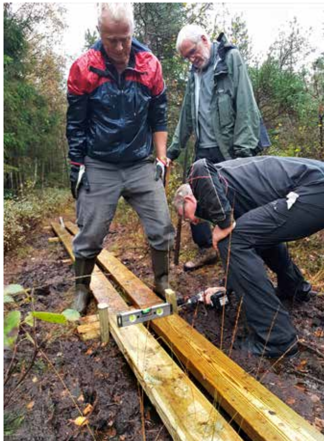
Arbeid ved Langemyra. Hans Nossen, Morten Skadsem og Jan Otto Johnsen i arbeid.
