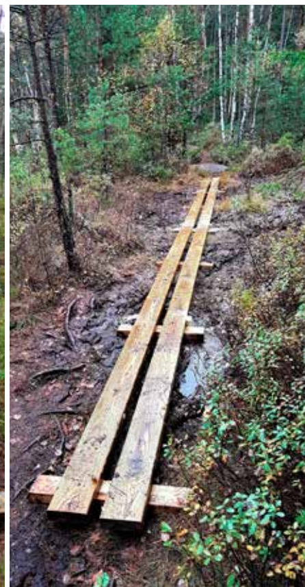
Ferdig gangbane ved Langemyra
