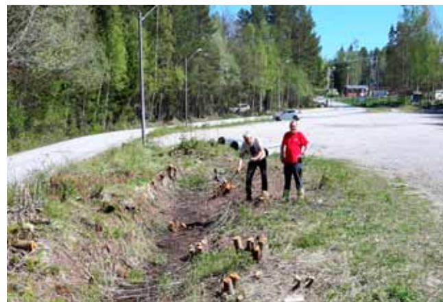
Kai Nilsen og Asbjørn Holmen viser hvor det skal graves og legges rør.
