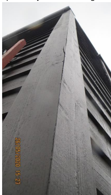
Bord mellom vinduer flasser. Bør skrapes om males
