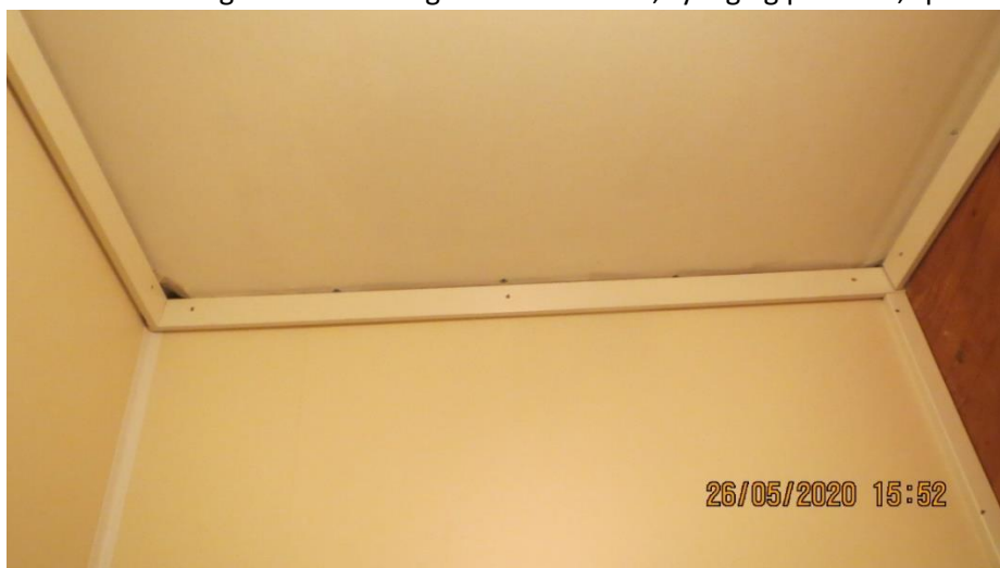
WC herre – Ved garderobe i 2 etg. Hull i tak tettes, synlige gipsskruer, sparkles og males
