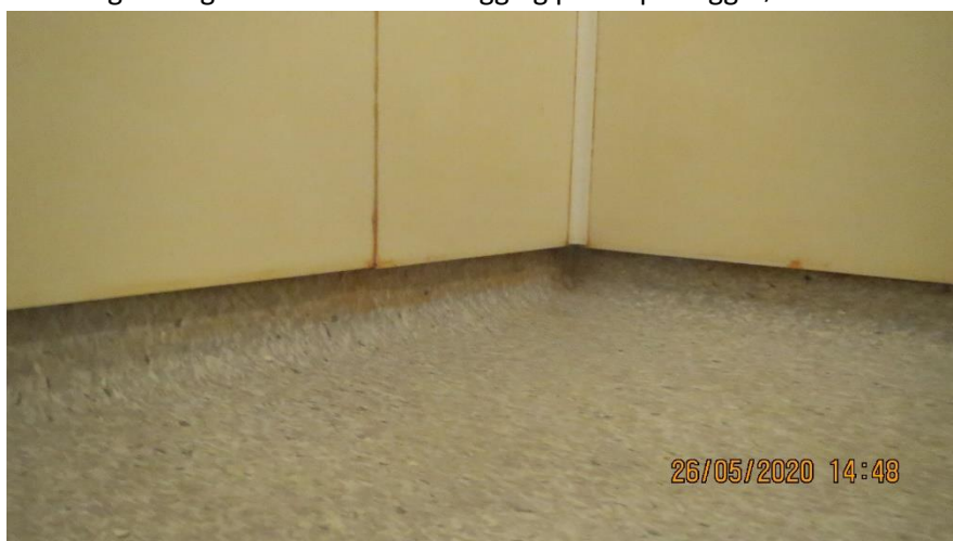
Gulvbelegg sprukket opp – fare for vannintregning.
