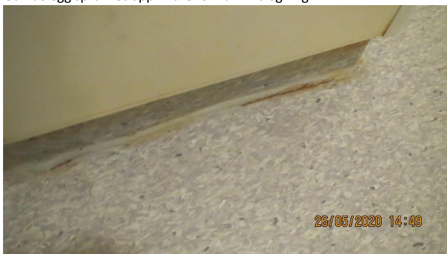
Gulvbelegg sprukket opp – fare for vannintregning.
