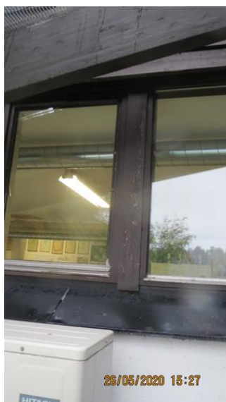
Bord mellom vinduer flasser. Bør skrapes om males
