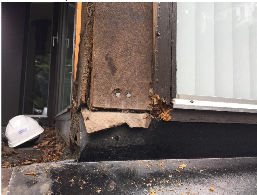
Bilder fra arbeidet på altanen
