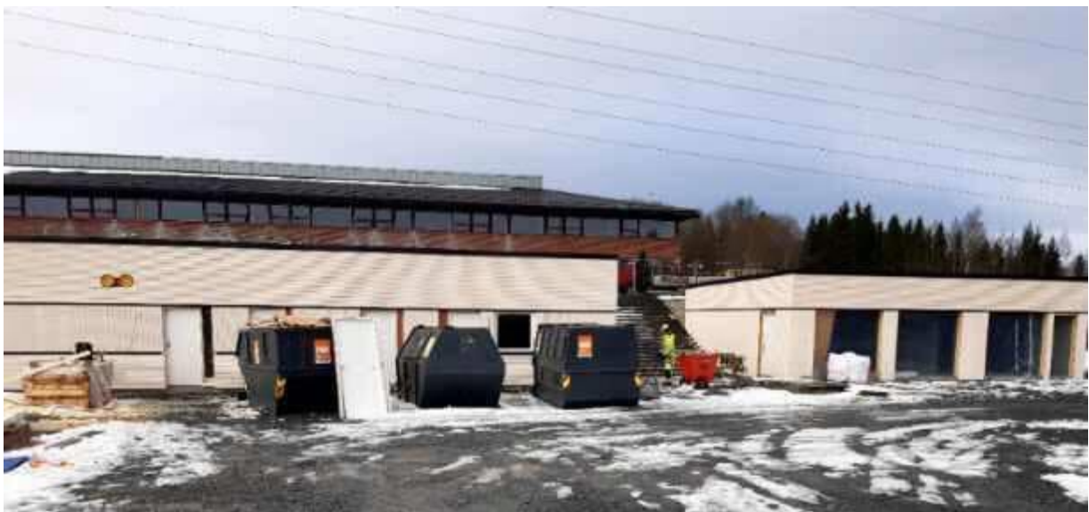
Bilde fra byggingen av nytt klubbhus og lager på Vinne Stadion
