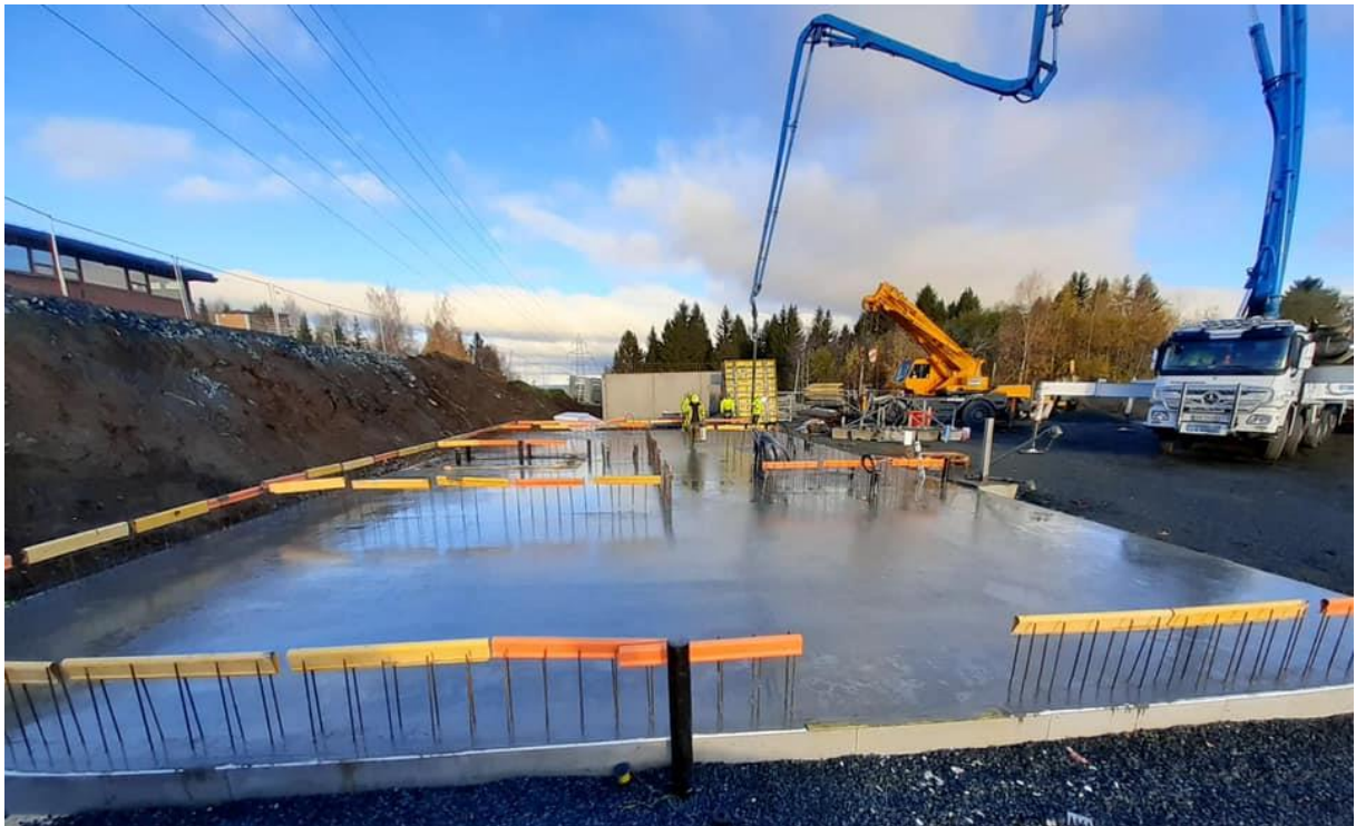
Bilde fra byggingen av nytt klubbhus og lager på Vinne Stadion
