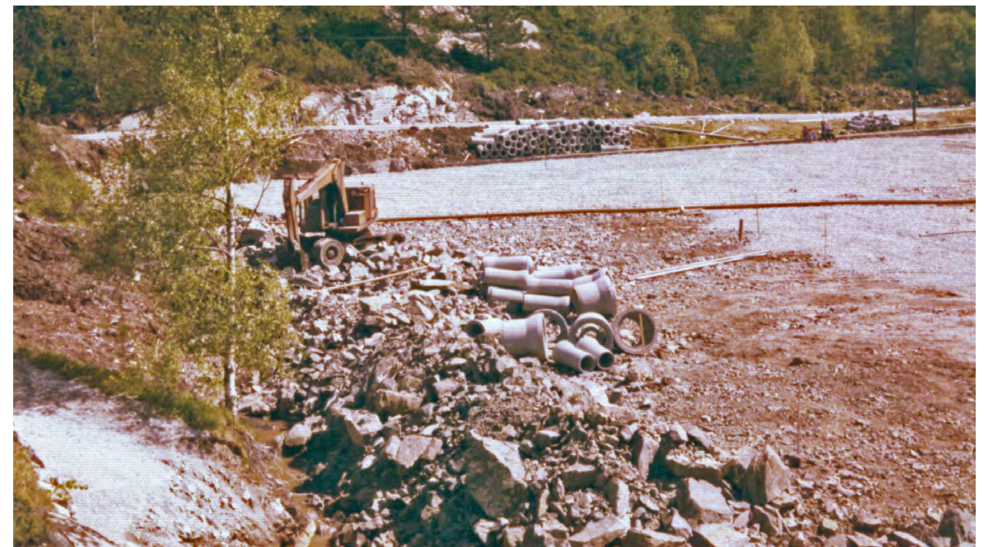
Planeringa av idrettsbana på Ostereidet under arbeid. Vegen opp til barneskulen er på plass.
