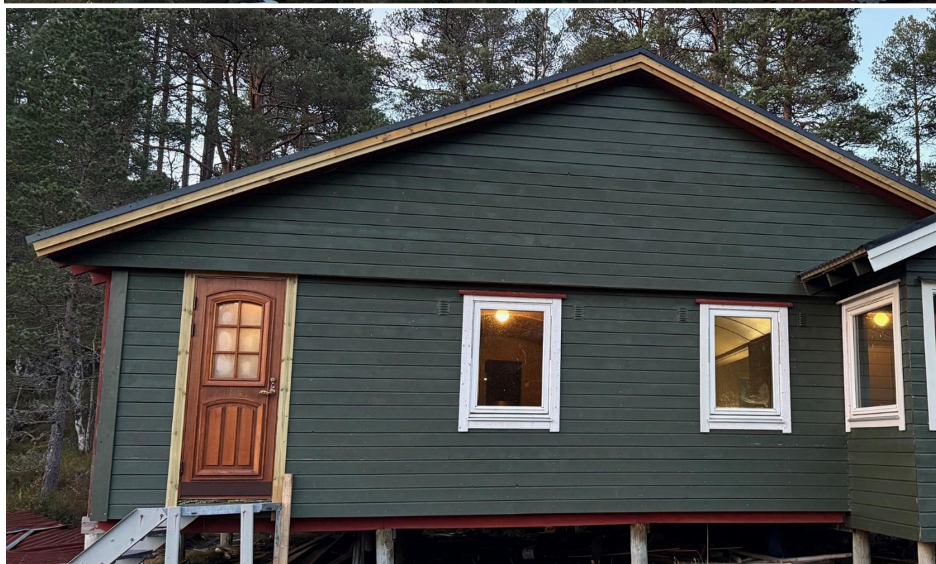
Klubbhuset med nytt tak, delvis ny kledning, ny dør og ny farge! Siste målejobben skal takast i vår.
