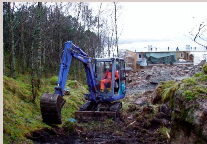
Grovplanering etter at vegetasjon er fjernet.
