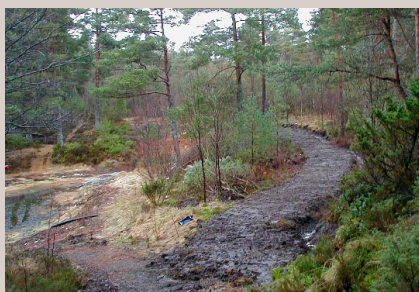
Grøfter og drenerør er nødvendig.
