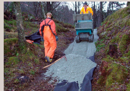
Utlekking av fiberduk.
