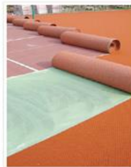
Clay Tech membranen limes til underlaget
