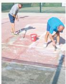
Eksisterende underlag rengjøres og kontrolleres
