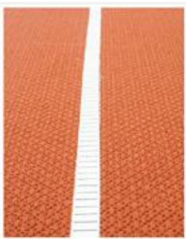
Tennislinjer limes til membranen (maling av linjer ved bruk av syntetisk grus)
