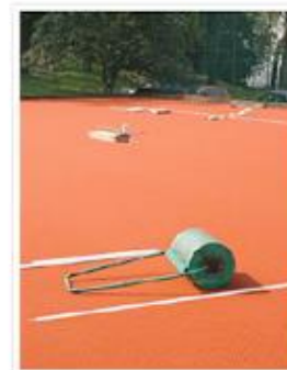
Clay Tech membranen valeses til underlaget
