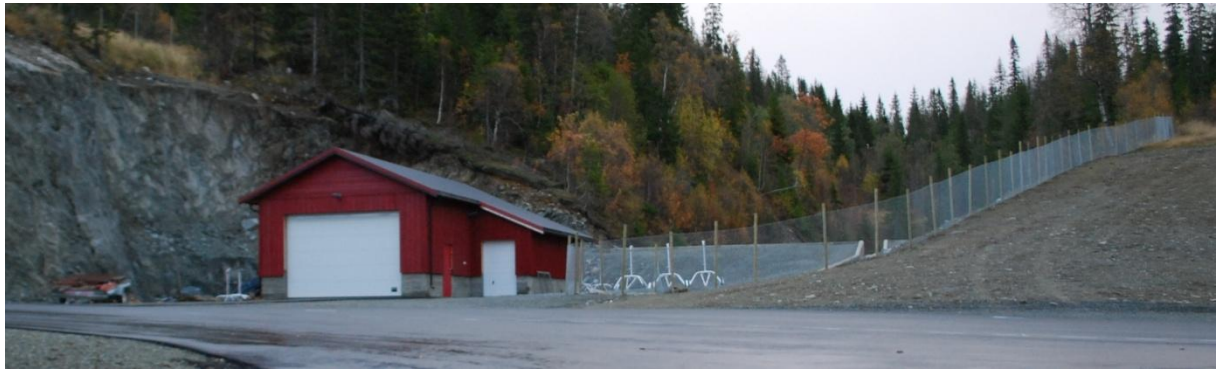
Garasje for tråkkemaskin, teknisk rom og vannmagasin.
