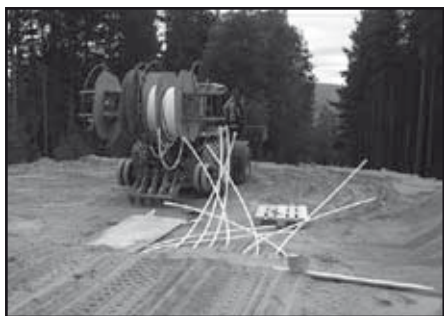
Svensk utleggermaskin for vannbåren undervarme under kunstgresset.
