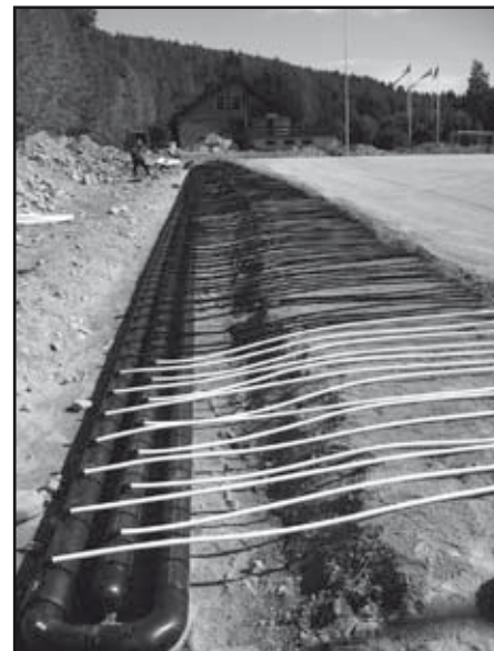
Undervarmen fordeler seg ut under banen. Smårørene går langs etter hele banen og kommer tilbake til materørene. De er ca 220m lange. Til sammen ble det lagt ned ca 3.6 mil med varmtvannsrør som varmer opp kunstgresset i de ca 3-4 mnd dette er nødvendig.
