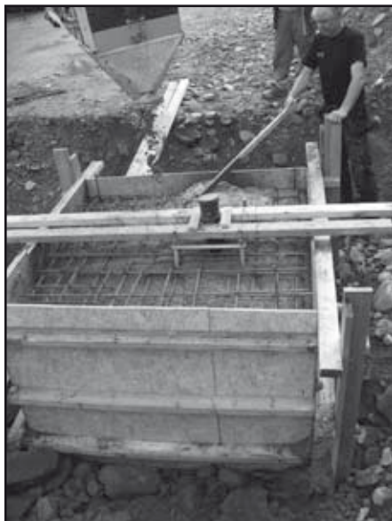
Forskalingen til lysmastene blir fylt med betong. Det gikk med 5m 3 betong, altså over 10 tonn til å holde fast hver mast.
