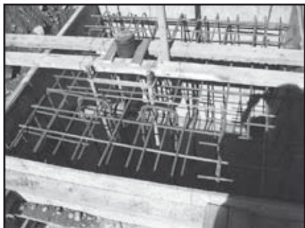
Armering av rørføringer for lyskabler og innstøpings-bolter for fester av mastene.
