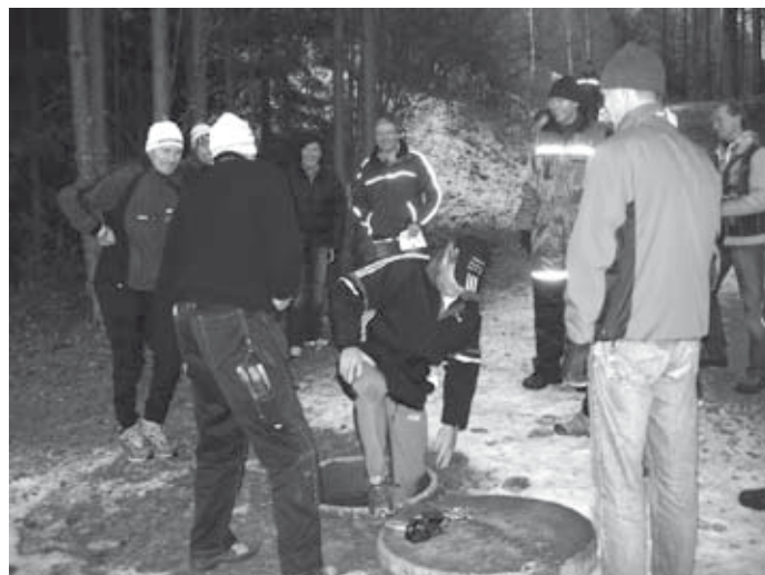
Bjarne Vidar Øen på vei opp av kummen der vannet kommer inn.
