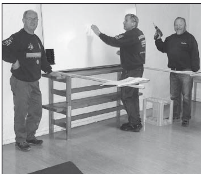
Torbjørn Bjurstrøm, Finn Kopperud og Ole Martin Fjeldstad monterer tavler i kjellerrom.
